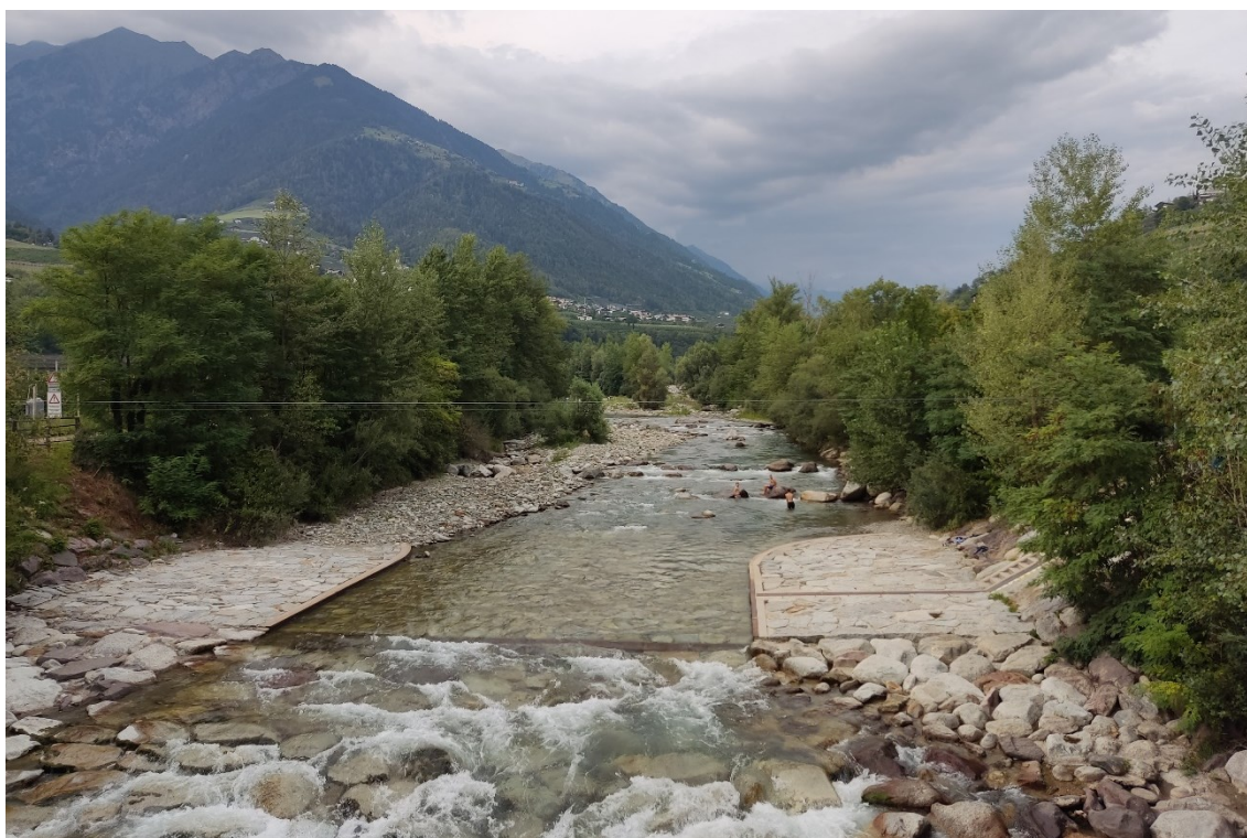
Figura 11 | Vista del torrente Passirio dal ponte ciclopedonale "Isola del Passirio"
